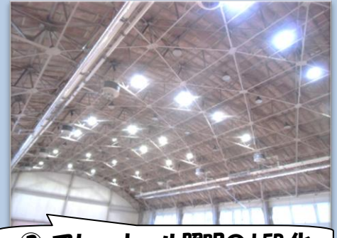
② プレーホール照明のLED化
